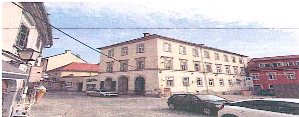
Prikaz stavbe 400-925, Slomškova 9, Ptuj
